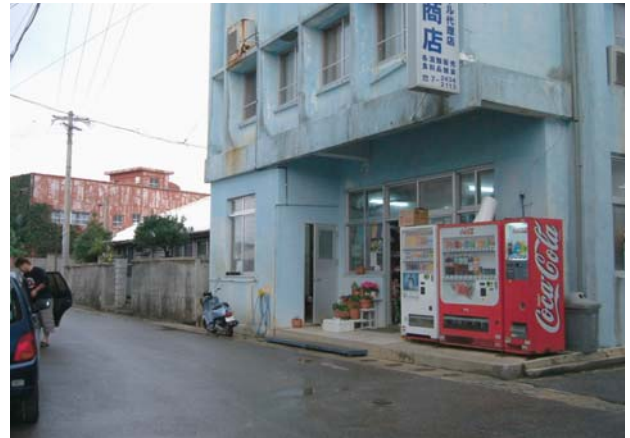
写真5 「はま・やてい」(浜小屋) 跡
