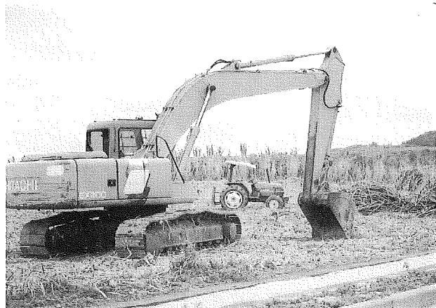
写真2 耕起用パワーショベル
