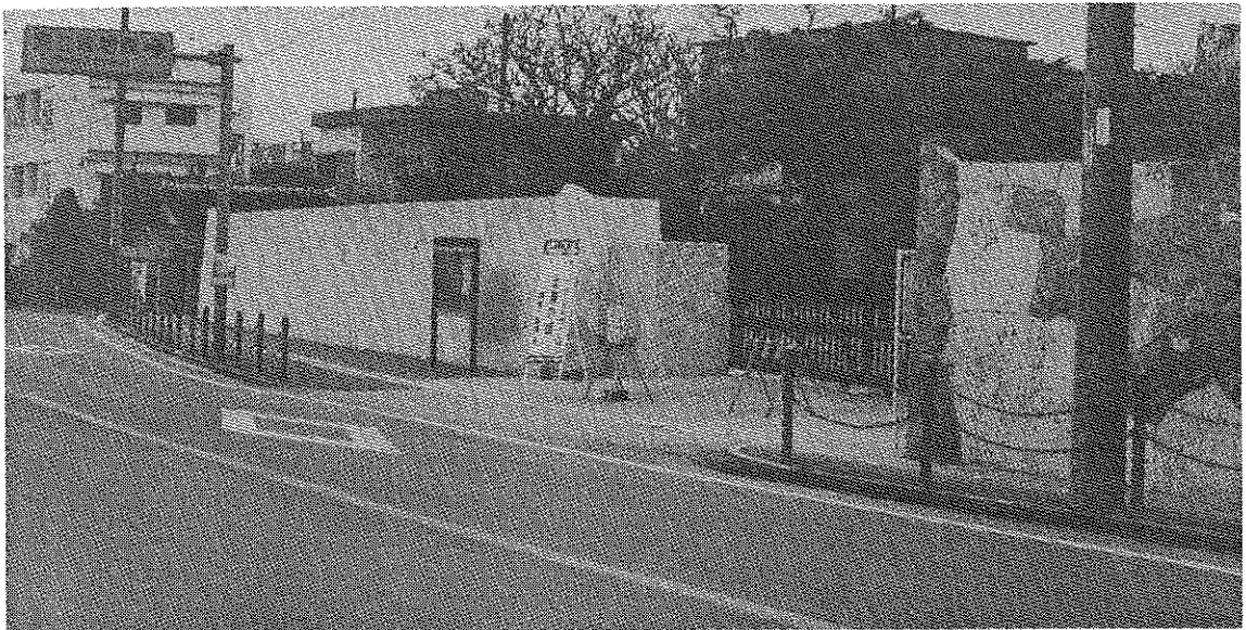
真新しくなった石垣（当館正門）
