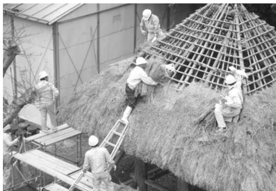
高倉の解体作業
