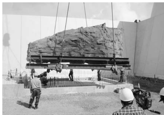
屋外展示場への設置作業
