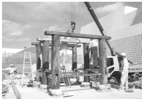
高倉の組立作業
