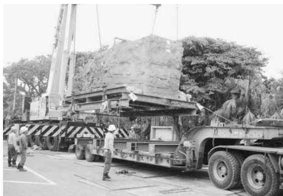
トレーラーへの積み込み作業
