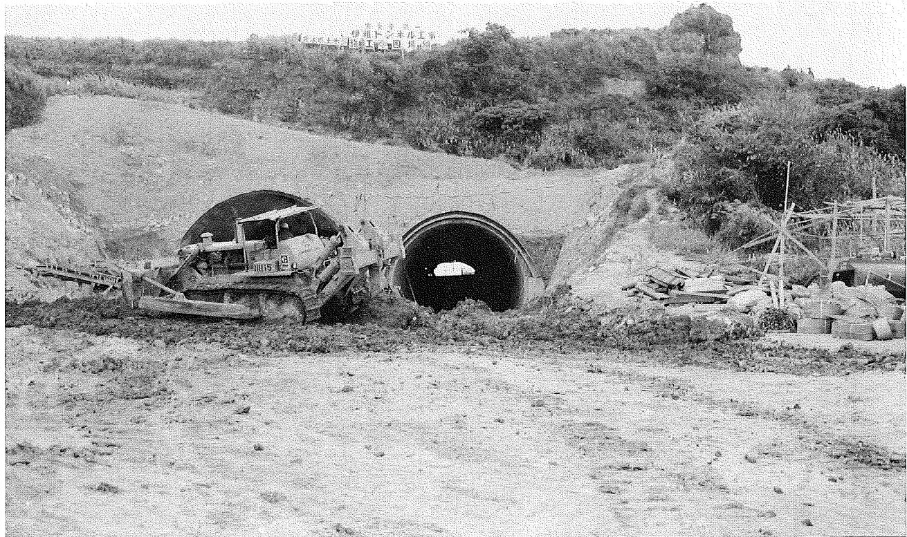
図版22 トンネル工法により保存された浦添貝塚（写真右上・1973年撮影）
