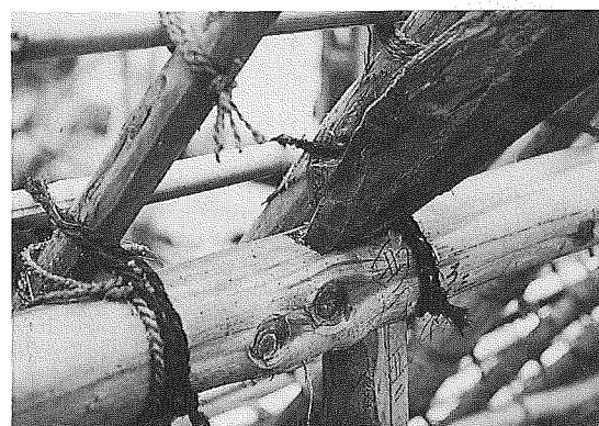
写真13：地回り桁と平叉首の接合部（西面）；南東側内から撮影
