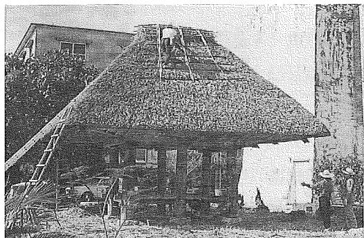
写真3：高倉の移築組立作業
