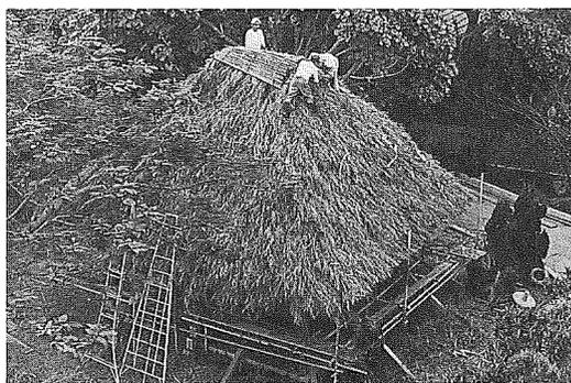
写真4：高倉屋根葺き替え作業
