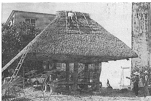
写真3：高倉の移築組立作業
