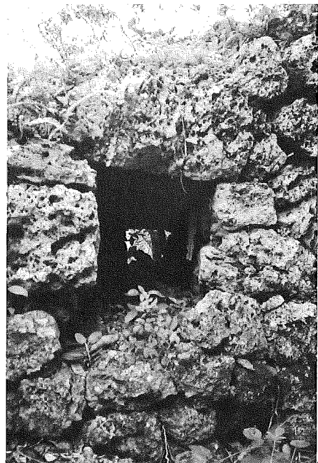
図版-3 安慶名城の城壁に設けられた狭間
