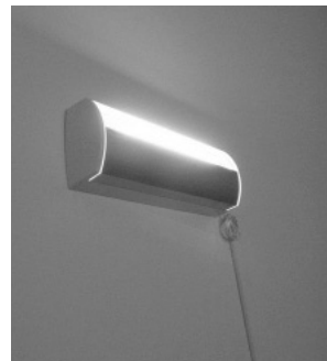
写真3 ライトトラップ設置状況
