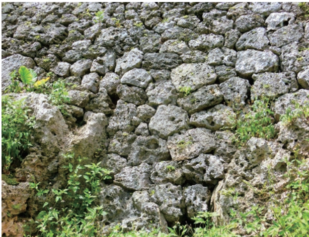
写真4 安慶名グスク石積み 粗割石Ⅰ
