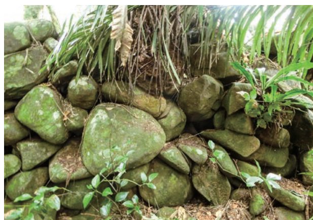
写真16 塩原グスク石積み 自然石（安山岩）
