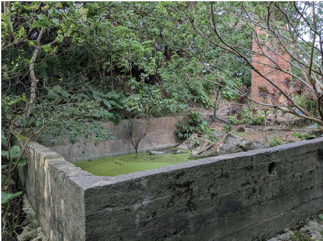
写真図版 8 平敷屋製糖工場跡煙突に隣接する水槽
