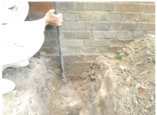
図28 煙突基礎部掘削状況
