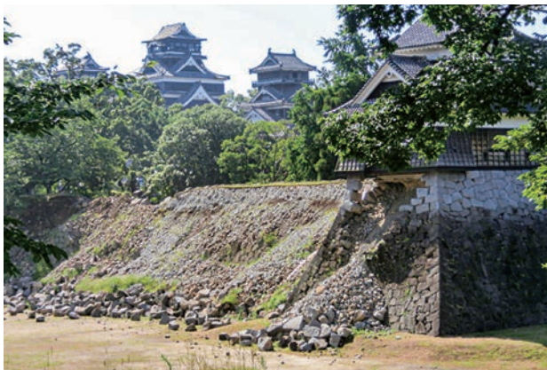
写真 26. 面石が崩壊した熊本城の城壁
