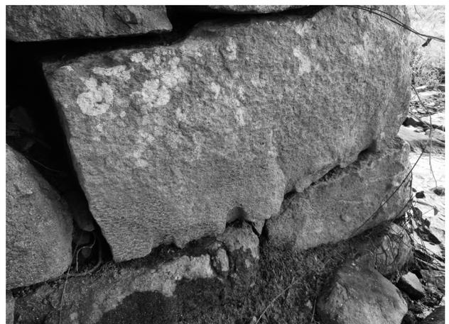
写真3 下村城堡 西側城門基礎近くの石材に残る矢穴
