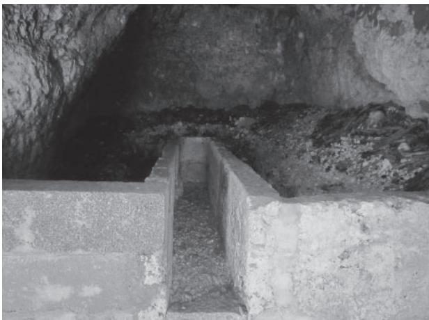
写真9.トーシー墓の墓室内部
