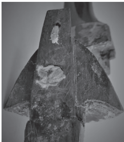
図12 鳩胸と心部分の凸状継ぎ部分（八の字状に形成）
