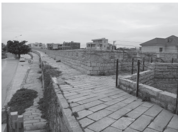
写真51 福全所城 整備完了後の城壁
