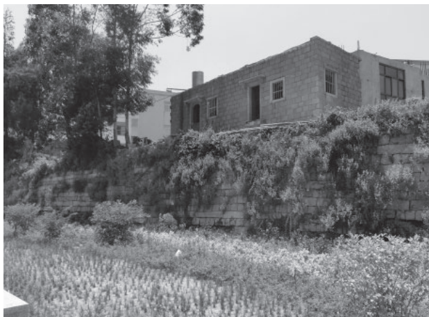
写真43 莆禧所城 西側城壁
