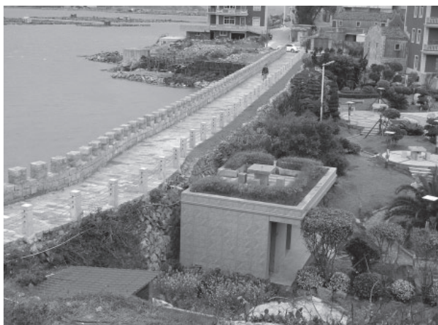
写真32 万安所城 北側城壁上部
