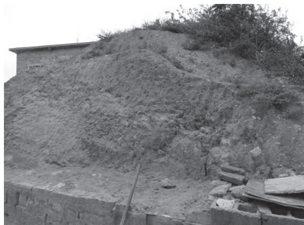
写真58 福全所城 東側城壁切通し断面
