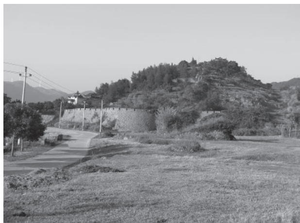
写真10 大金所城 遠景（北東から）
