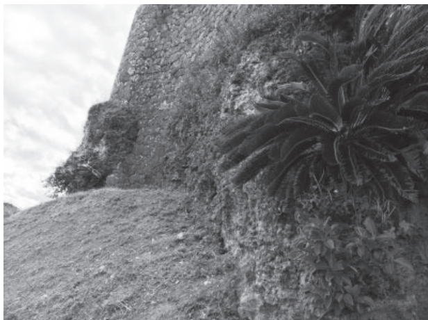
写真4. 琉球石灰岩の岩盤上に積まれた石積み（勝連グスク）
