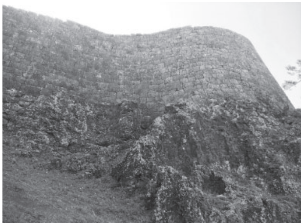
写真5. 琉球石灰岩の岩盤上に積まれた石積み（浦添グスク）
