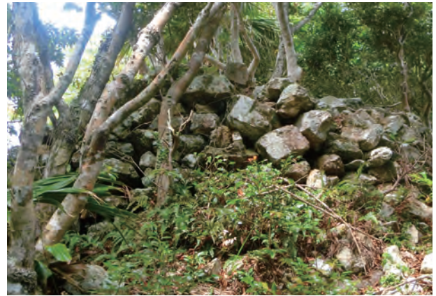
写真9 北東隅の石積み
