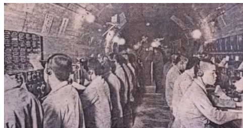
第五航空艦隊司令部地下壕電信室 (情報局 1945『写真週報』第371号より)
