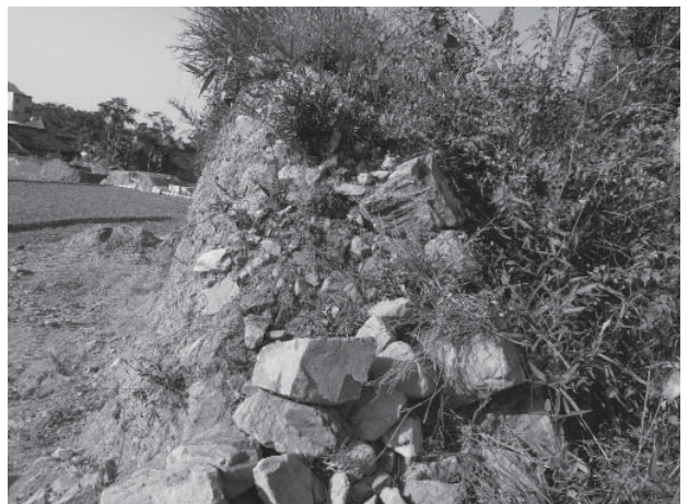
写真12 長溪城堡城壁断面
