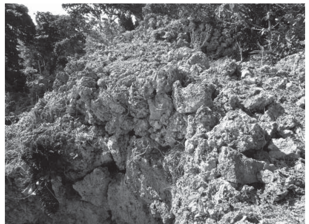
写真15 石灰岩盤上に設置される石積み(伊波グスク)
