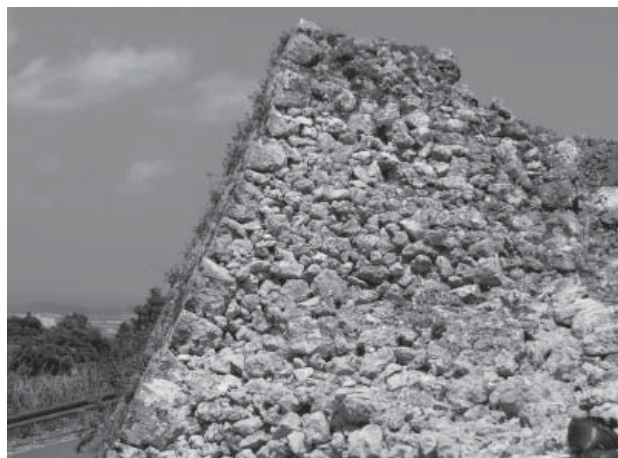
写真16 中城グスク石積み断面
