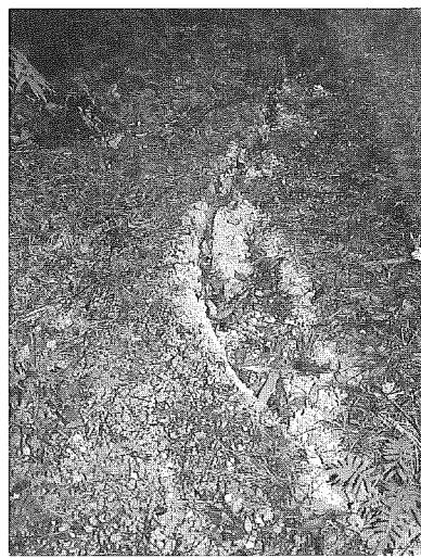
図25 西表島群発地震でできた地割れ
