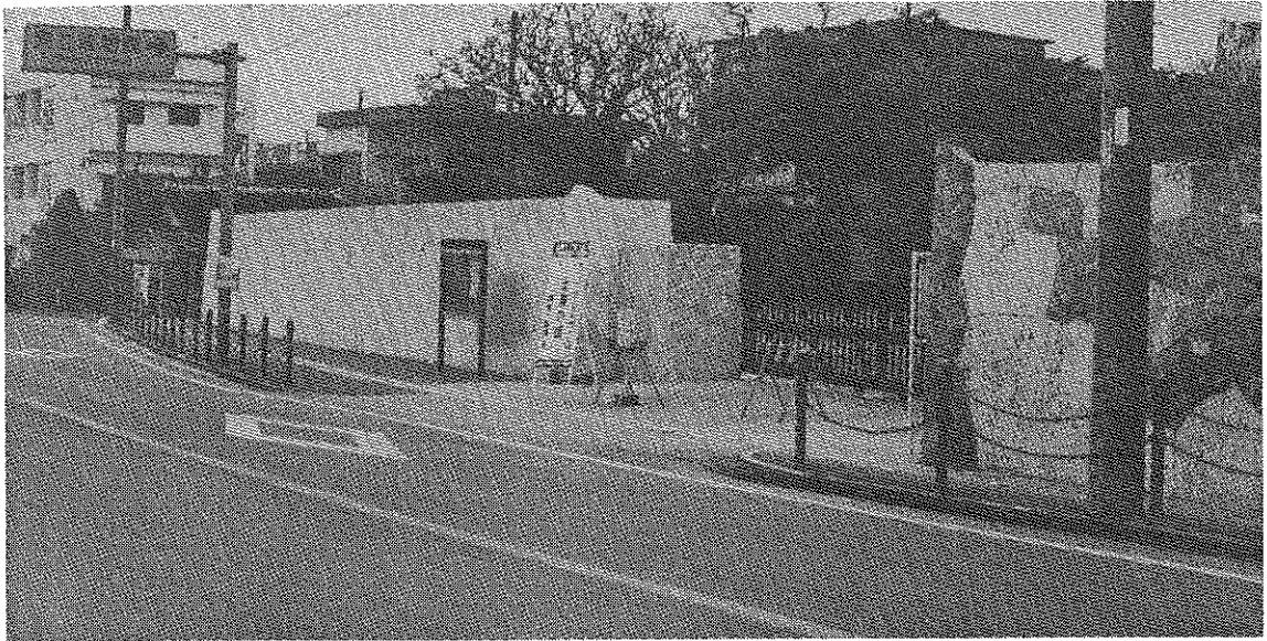
真新しくなった石垣（当館正門）
